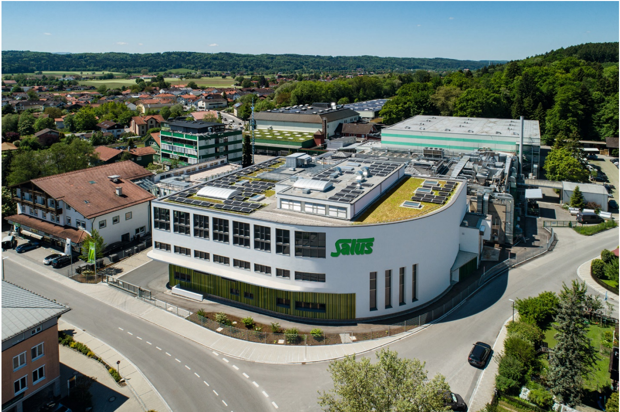
Im Vordergrund der neue Erweiterungsbau am Salus-Firmenhauptsitz im oberbayerischen Bruckmühl
